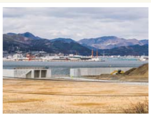
大船渡の沿岸では防潮堤の建設が進む
