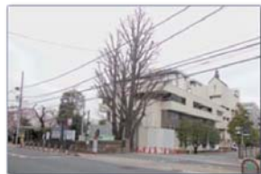
解体前 (撮：平成27年3月正門側)
