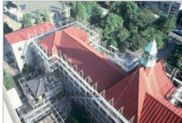
昭和54年 北里研究所本館建物解体
