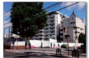
解体後 (撮：平成27年6月正門側)
